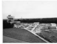
1965-1968. Bâtiments de la première tranche, CELAR, Bruz (Ille-et-Vilaine) : vue générale du site en chantier, 3 sept. 1968 (cliché GALAT 3). (Dossier 112 Ifa 1500/35. Doc. NR-10-12-09-03)
