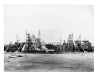
Gustave Eiffel (ing.). 1889. Tour Eiffel, Paris 7e : vue de la construction des piliers de la Tour, août 1887 (cliché Louis-Emile Durandelle) [cliché contemporain du Studio Chevojon]. (Sélection de documents numérisés représentatifs du fonds. Doc. AR-20-07-09-04)
