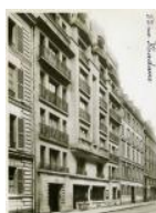
Jean Boucher (arch.). 1931. Immeuble, 52 rue Madame et 5 rue Jean-Bart, Paris 6 : vue de la façade sur la rue Madame, n.d. (cliché Chevojon). (Sélection de documents numérisés représentatifs du fonds. Doc. AR-05-08-09-01)
