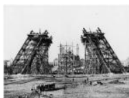
Gustave Eiffel (ing.). 1889. Tour Eiffel, Paris 7e : vue de la construction des piliers de la Tour, 7 déc. 1887 (cliché Louis-Emile Durandelle) [cliché contemporain du Studio Chevojon]. (Sélection de documents numérisés représentatifs du fonds. Doc. AR-20-07-09-07)
