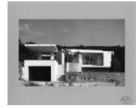
1963-1968. Maison pour Jacques Poncharal, Grimaud (Var) : vue ext., n.d. (cliché anonyme). (Dossier 200 Ifa 914/2. Doc. 233-P-03)
