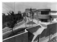
1933-1938. Groupe scolaire Marius-Jacotot, Puteaux (Hauts-de-Seine) : vue ext. d'ensemble, n.d. (cliché anonyme). (Sélection de documents numérisés se rapportant au projet. Doc. D-33-13-59)
