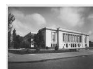
1930-1934. Concours et réalisation. Hôtel de ville de Puteaux (Hauts-de-Seine) : vue générale. (Sélection de documents numérisés se rapportant au projet. Doc. D-33-10-25)
